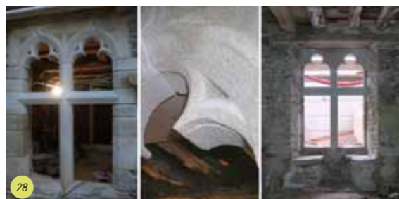
Photo 27 : maison, 17 rue Saint-Guénhaël, premier étage, coussièges dégagés après piquage des enduits de plâtre.
