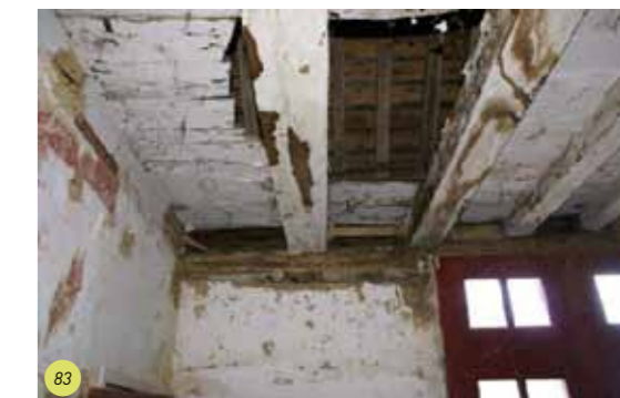
Photo 83 : 2 e étage : dépose du plancher pour dégager des abouts de solives et relever leur jonction avec les pieds de charpentes
