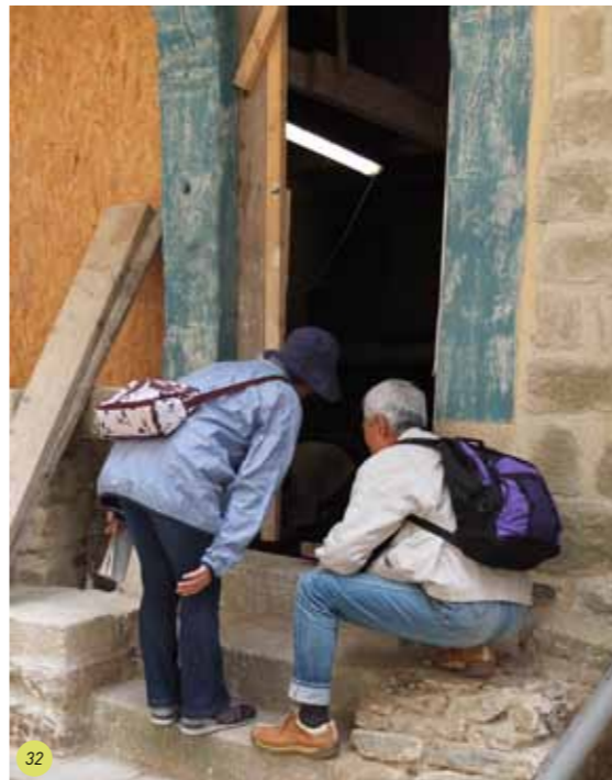
Photo 32 : maison, 19 rue Saint-Guénhaël, couple de touristes japonais s'intéressant aux travaux en cours (photo J.P. Leconte été 2012).
