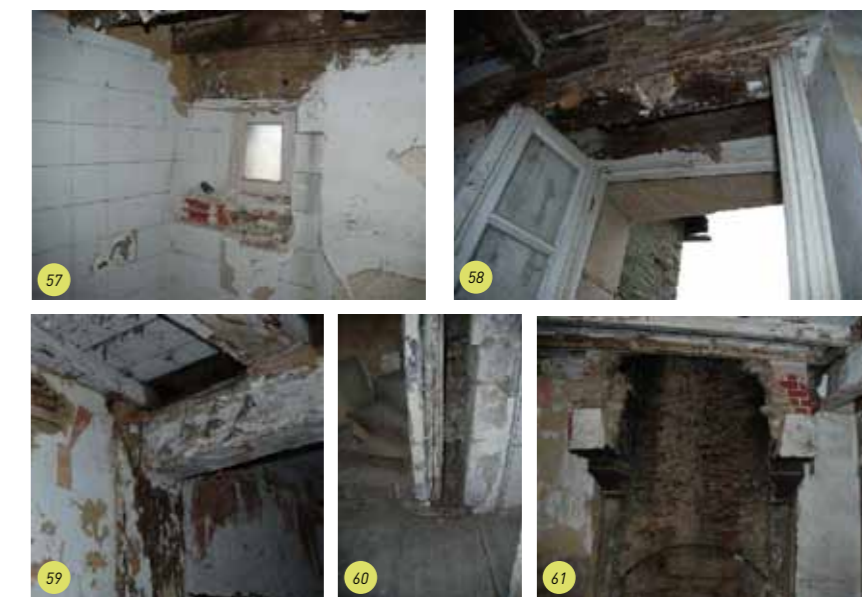
Photo 56 : plan du 2 e étage Photo 57 : vue d'une salle d'eau installée dans la tour Photo 58 : vue d'un arrière linteau de la façade arrière Photo 59 : vue d'un about de poutre Photo 60 : vue du départ de l'escalier du comble Photo 61 : vue de deux piédroits de cheminée
