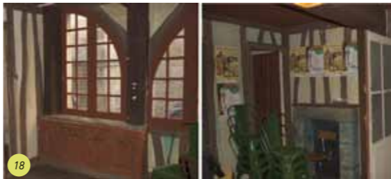
Photo 17 : Maison, 17 rue Saint-Guénhaël, rez-de-chaussée, arcs en tiers point et trace de maçonneries appareillées.
