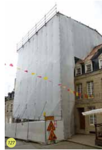
Photo 125 : vue du parapluie en cours de préparation au sol Photo 126 : vue du parapluie en cours de montage Photo 127 : vue d'ensemble de l'échafaudage et du parapluie terminés Photo 128 : vue de la charpente après dépose de la couverture Photo 129 : réalisation d'échantillons de joints et d'enduits Photo 130 : vue de la charpente après dépose de la couverture Photos 131 et 132 : vues de l'état de dégradation des planchers et abouts de poutres Photo 133 : reprises de maçonnerie et de percements en cours Photo 134 : vue du pan de bois après enlèvement du torchis Photos 135 et 136 : découverte d'un pan de bois noyé dans la maçonnerie de la façade arrière Photo 137 : détail de l'état de dégradation des bois de la façade Photos 138 et 139 : fenêtre à plis de serviettes découverte derrière une cloison Photos 140 et 141 : vues de l'état de dégradation des assemblages entre les planchers et la façade Photos 142 et 143 : vues de la charpente déposée
