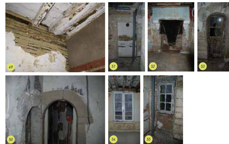
Photo 48 : plan Photo 49 : vue de l'état des enduits et planchers Photo 50 : vue de deux portes en plein cintre dans la tourelle Photos 51 à 55 : vues de détails de portes, fenêtres et d'une cheminée
