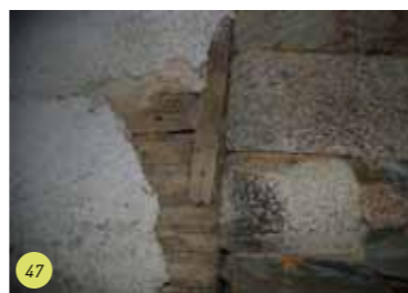
Photos 41 à 44 : Vues de différentes portes du passage traversant Photo 45 : Vue vers la rue Photo 46 : Vue depuis l'arrière Photo 47 : Vue de la liaison mur maçonné et cloison rapportée
