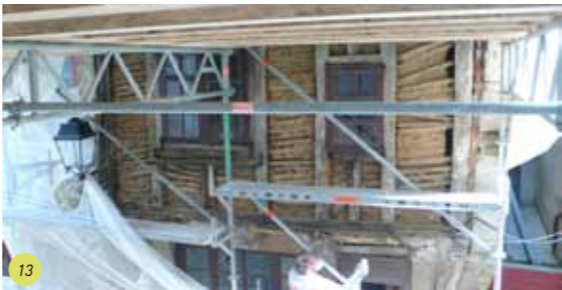
Photo 14 : maison, 19 rue Saint-Guénhaël, pans de bois : traces de couleur et essai de réinterprétation.
